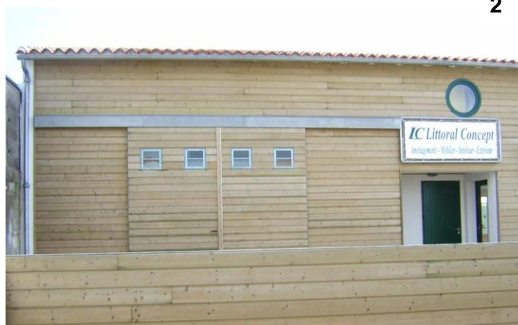
Bâtiment d'activité en bois
