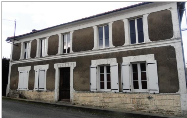
Maison de bourg avec enduit à la tyrolienne
