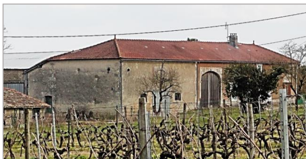
Imposant corps de ferme muni d'un porche central et d'une toiture à croupes
